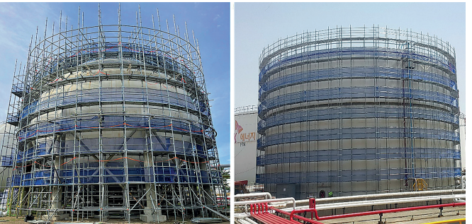
(주)디아엔지니어링의 원형 시스템 비계. 세계 최초로 개발돼 현장에 적용된 볼 탱크(Ball Tank) 전용 시스템 비계이다.
